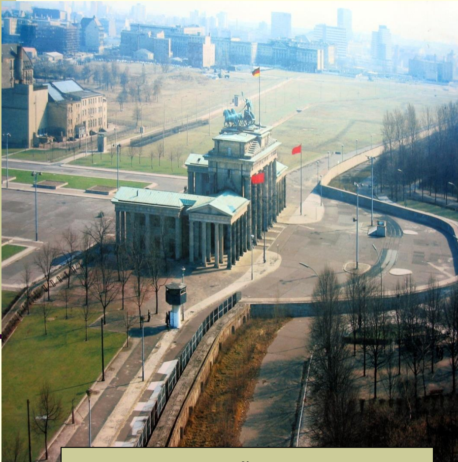
CONSTRUÇÃO DO MURO
